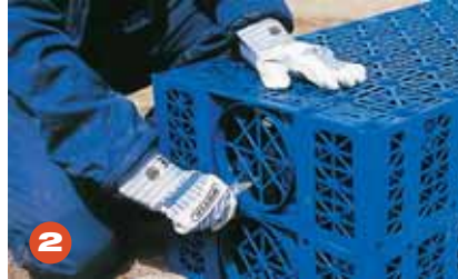
2 Kasetti leikataan auki tuloyhteen asennusta varten. (Aukon koko D160.)
