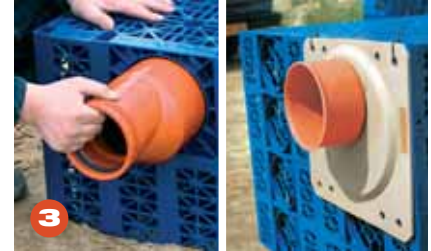
3 Tuloyhde asennetaan kasettiin. Käytä tarvittaessa supistusyhdettä 160/110. Suurempia yhdekokoja D200...D300 varten tarvitaan liitoslevy.
