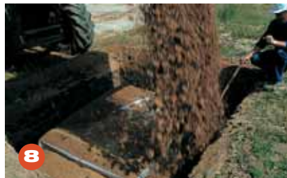
8 Hiekkatäyttö suoritetaan kivettömällä asennushiekalla, täyttäen tasaisesti makasiinin ympäristä. Täyttöä ei saa suorittaa reuna kerrallaan. Täyttöhiekkä tiivistetään huolellisesti niin makasiinin reunoilta kuin päältäkin.
