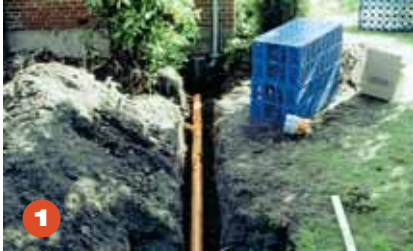
1 Kasetit voidaan asentaa joko rinnakkain tai sarjaan ja enintään 6 kasettia päällekkäin.
