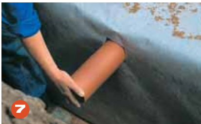
7 Suodatinkangas asennetaan kasettien yli. On varmistettava, että suodatinkangas peittää koko makasiinin.
